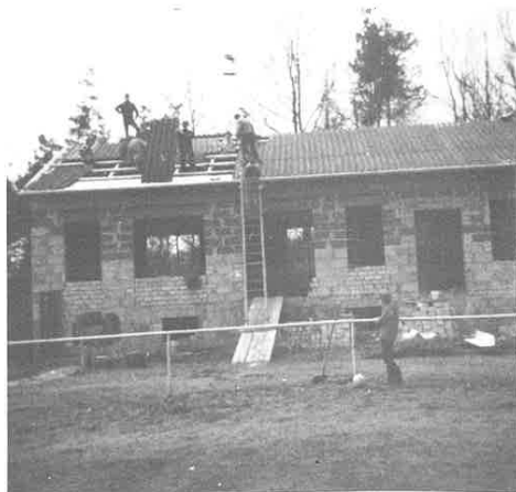
Eifrige Helfer beim Bau des neuen Sportheimes.
